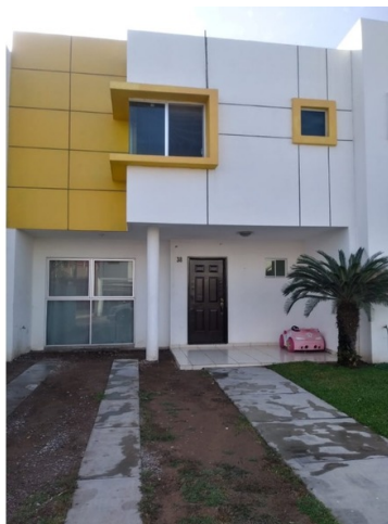
UBICACIÓN DEL INMUEBLE Ave. Bariloche 3000-38, Avellaneda Culiacán, Sinaloa
